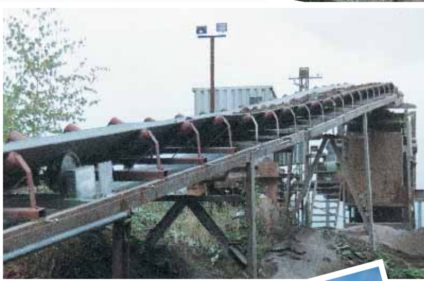
Beispiel 4: FMS Förderbandwaage im Brecherabzugsband eines Lavalitbruchs. Kapazität 400t/h
